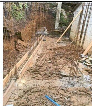
Foto 4: Avance del suministro e instalación de pared de block y columnas
