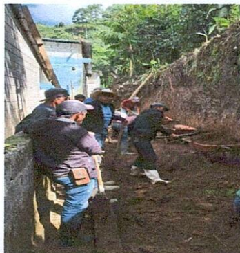
Foto 2: Antes de iniciar los renglones de trabajos priorizados del remozamiento.
