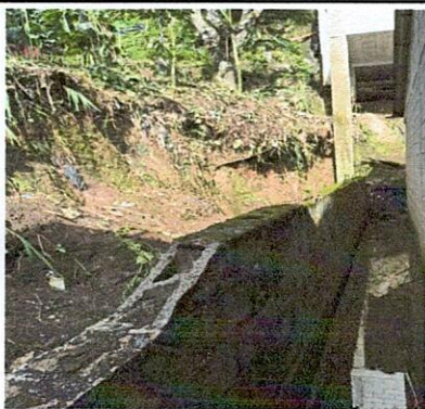
Foto 1: Así se encuentra el predio antes de iniciar los trabajos.
