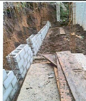
Foto 6: Avance de los suministros en instalación de pared.
