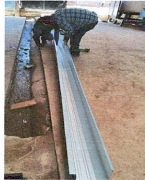
Foto: Inicio de la instalación del canal de bada de agua pluvial.
