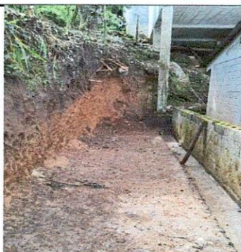
Foto 3: A vance de trabajos en preparación del terreno para la instalación de pared.
